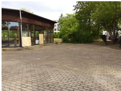
Entkernter Pavillon-Rohbau mit Parkplatz von Fichtestraße aus 2022
