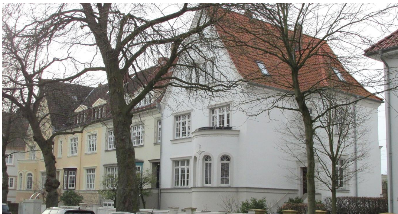
Straßenansicht · Die Einfriedung wurde inzwischen erneuert.
