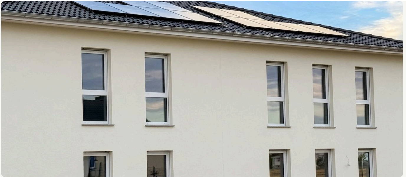
Straßenansicht des Hauses
