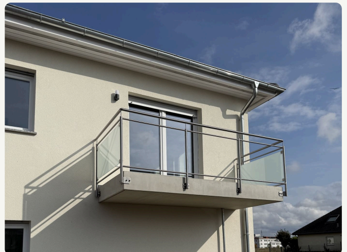
Balkon OG · Bauzustand Oktober 2026
