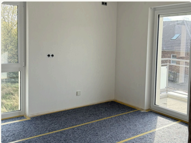
Wohnbereich OG mit Balkontür · Bauzustand Oktober 2026
