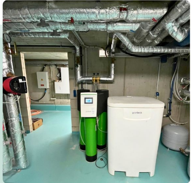
Wasserenthärtungsanlage
