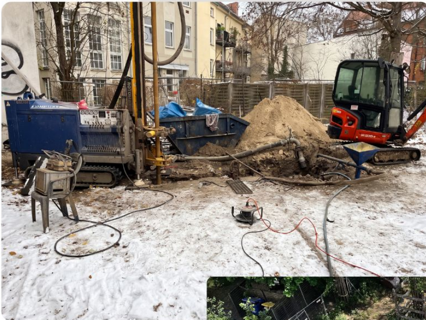
Bohrung der 99 m tiefen Erdsonden
