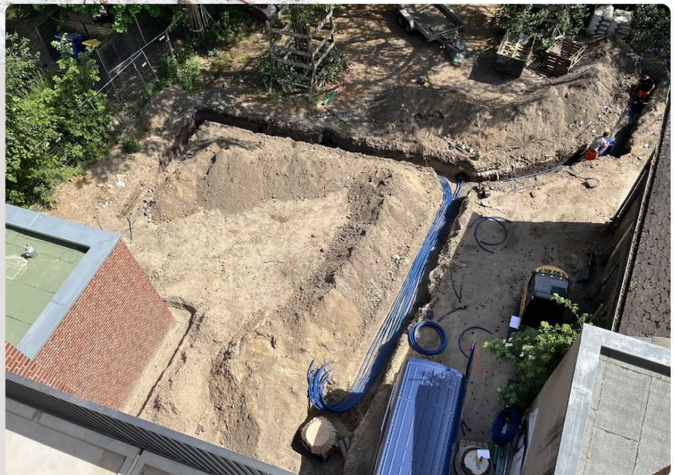
Unterirdische Verlegung der Soleleitungen von den Erdsonden zum Hauptschacht
