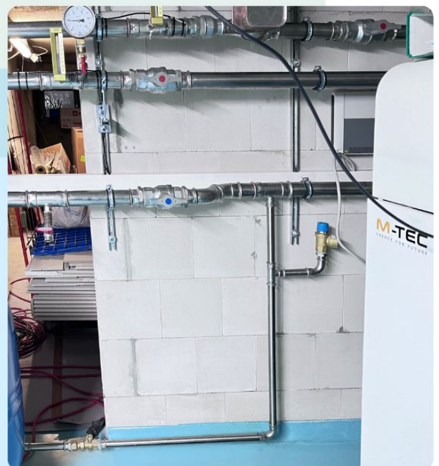
Edelstahlleitungen vor der Isolierung
