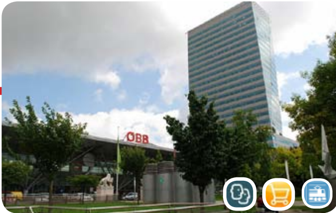
DER LINZER HAUPTBAHNHOF
