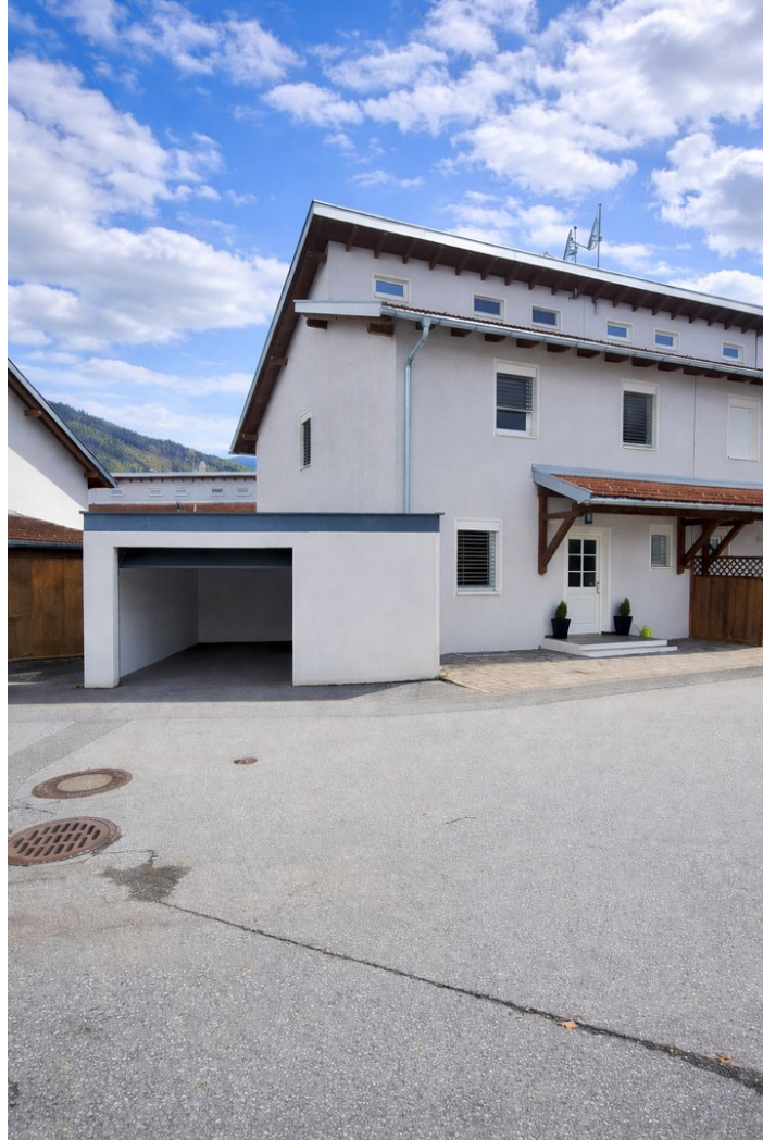
Haus Ansicht Garage
