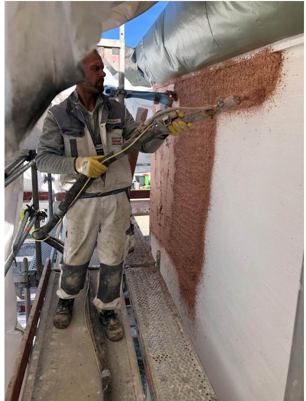
Maschinelles Auftragen
