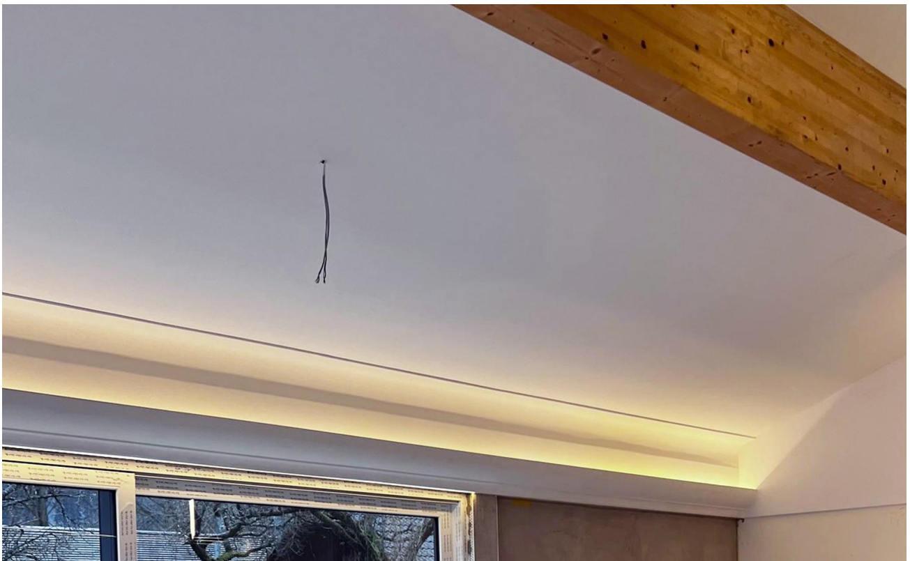
Detail Stucklichtvoute, Salon
