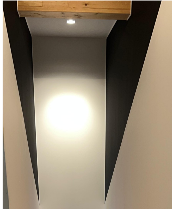
Teppe OG/EG (Ist-Zustand)
