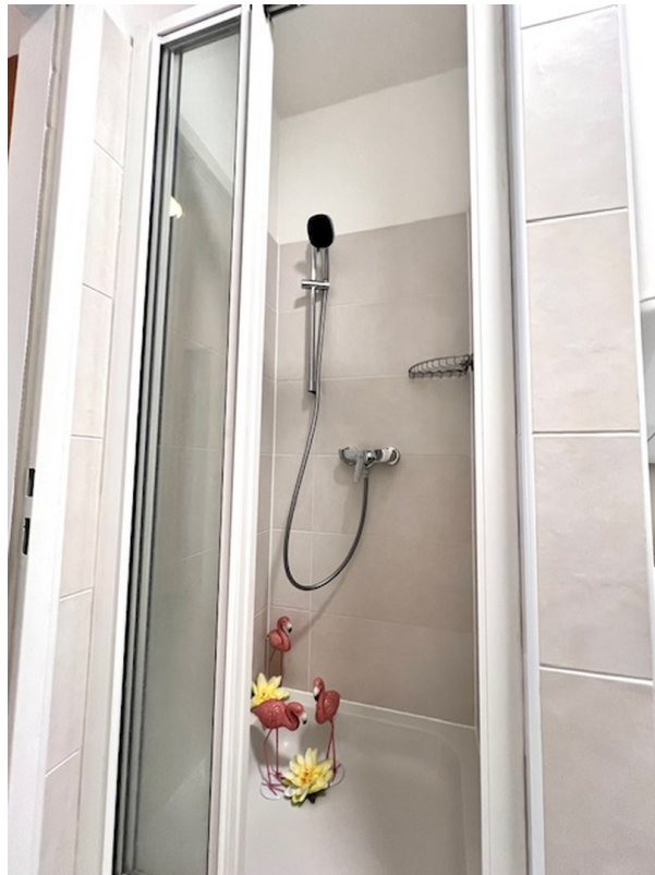
Dusche neue Armaturen
