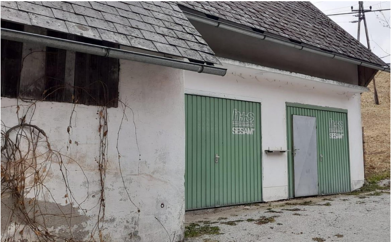
Doppelgarage mit Dachausbau
