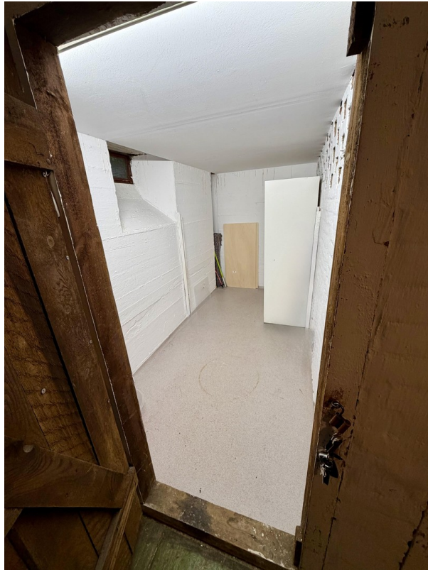
Keller mit Stromanschluss
