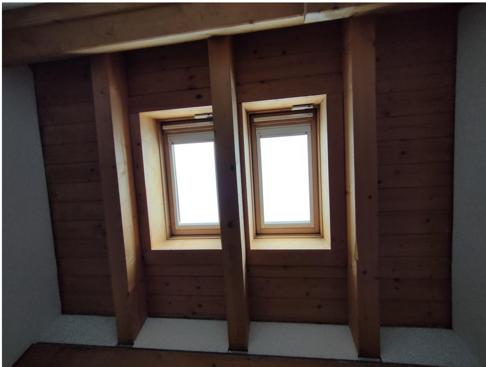
Dachfenster im Bad
