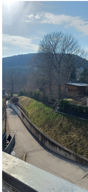
Blick zur Straße Westbalkon
