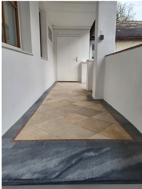
Blick auf den Eingang 1. St.
