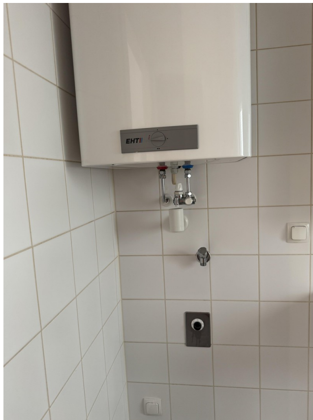
Boiler und Anschluss WM
