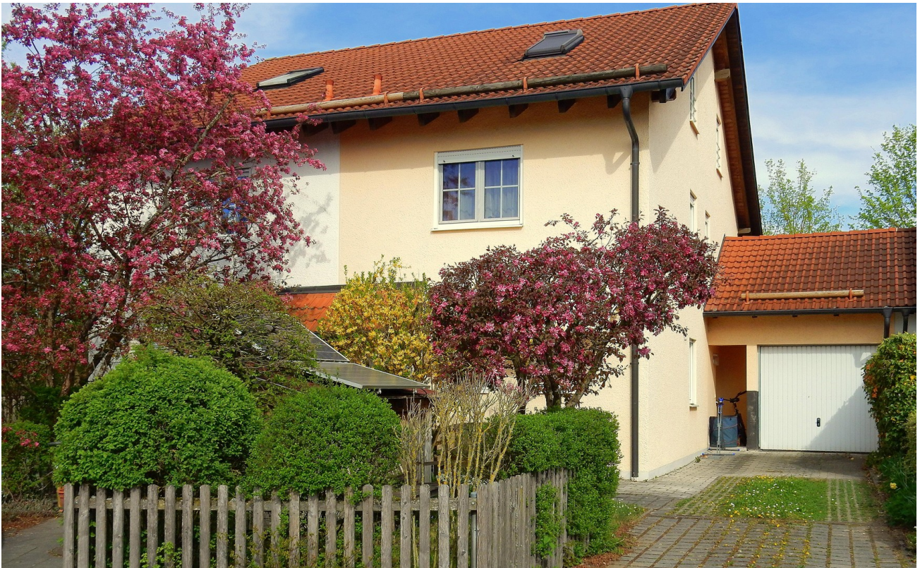
Westseite mit Garage
