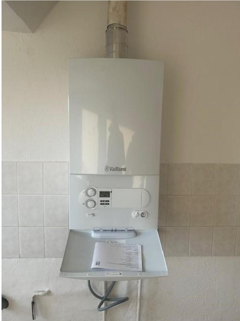
Neue Gasetagenheizung
