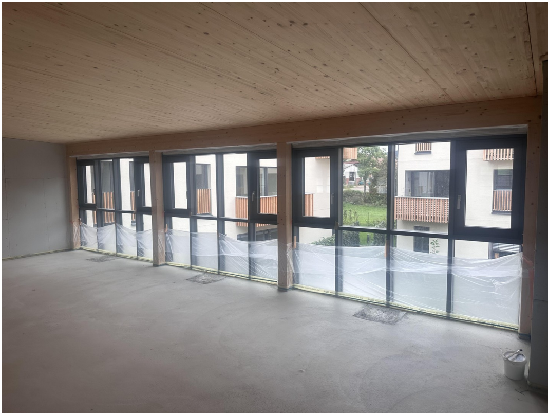
Fenster zum Innenhof
