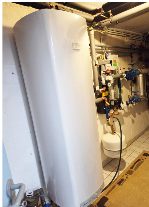
Heizraum mit Fernwärme-station und Boiler
