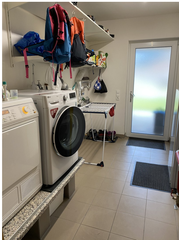
Heiz- und Waschraum
