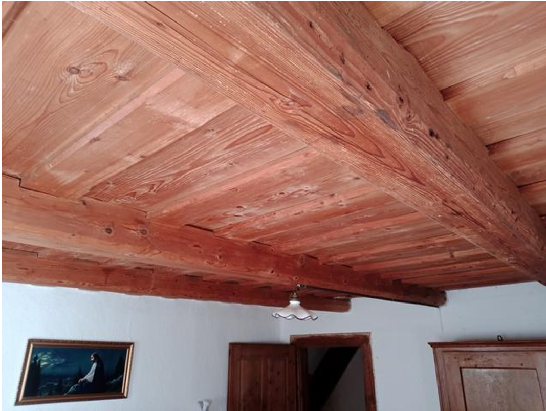
Deckenbalken und Holzdecken
